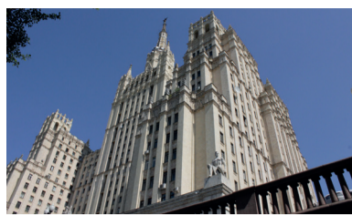
Скульптура Н.Б. Никогосяна в пространстве фасада и боковых крыльев высотного здания.
